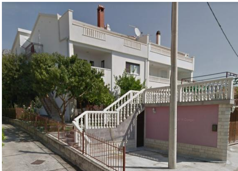
Slika 35. Izvedeno stanje predmetne građevine.
