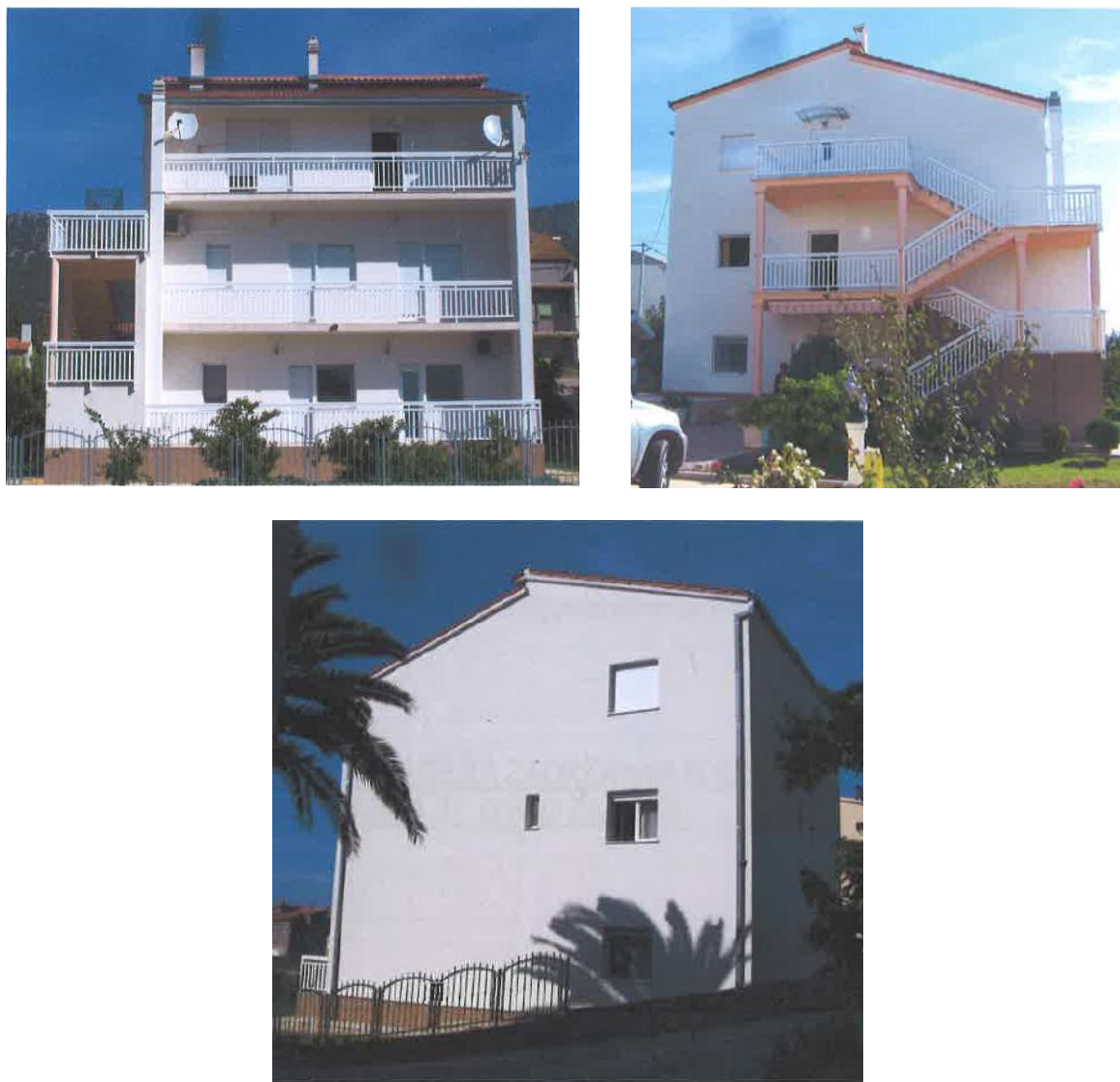
Slika 32. Izvedeno stanje predmetne građevine. (Preuzeto: Fotodokumentacija danim arhitektonskim snimkom)
