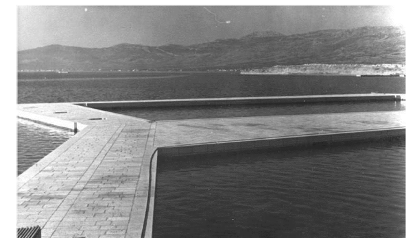
betonski bazen na Spinutu 1955. godina
