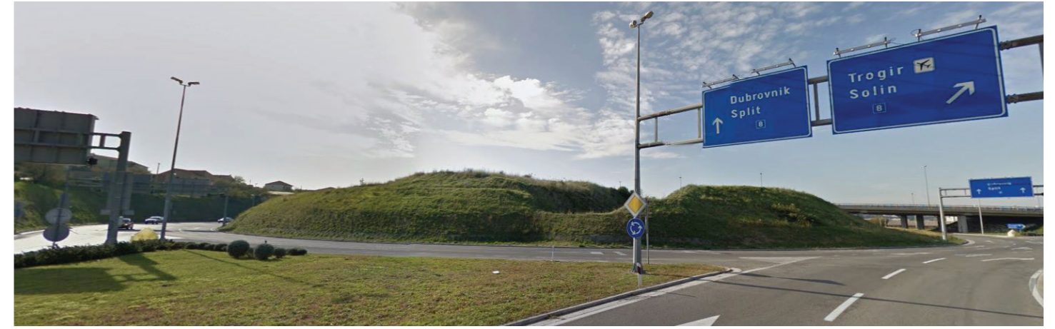
Pogled na lokaciju_priklučivanje ceste D1 na D8
