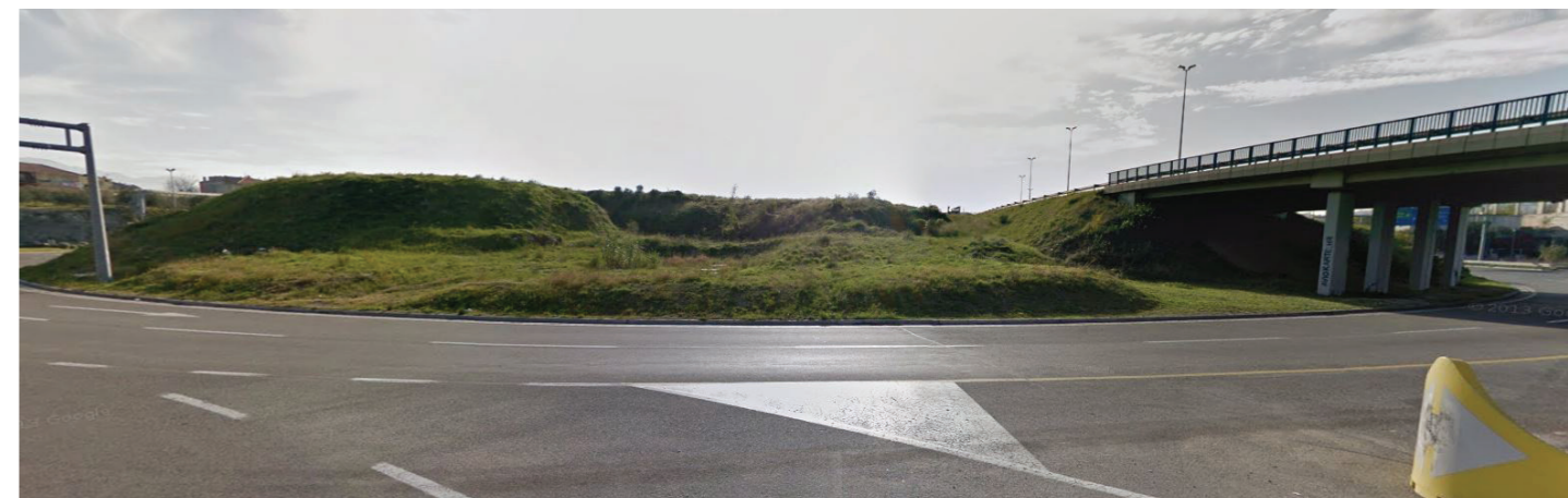
Pogled na lokaciju_sa priključkom na trgovački centar
