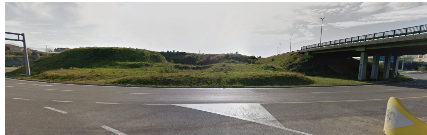
Pogled na lokaciju_sa priključkom na trgovački centar
