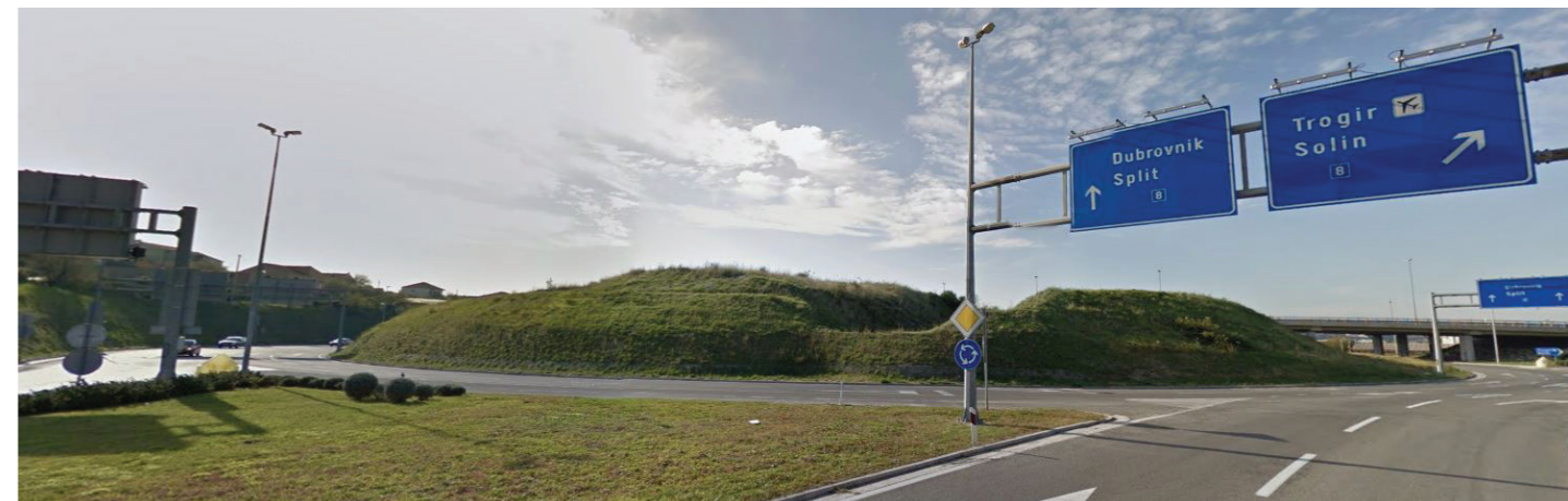
Pogled na lokaciju_priklučivanje ceste D1 na D8
