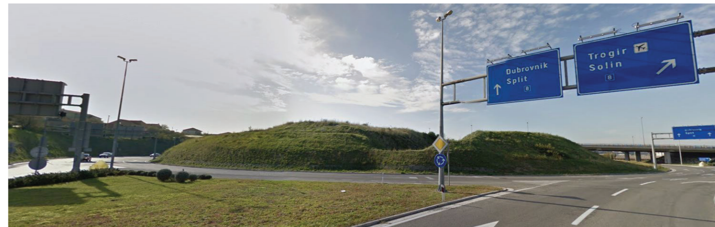
Pogled na lokaciju_priklučivanje ceste D1 na D8
