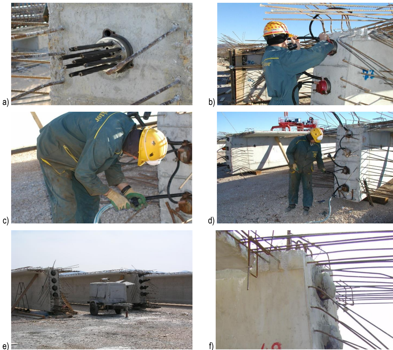
Slika 7.20 – Izvođenje naknadnog prednapinjanja nosača nekog mosta – Injektiranje morta
