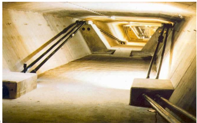
Slika 7.9 – Vanjsko prednapinjanje [20] & [21]
