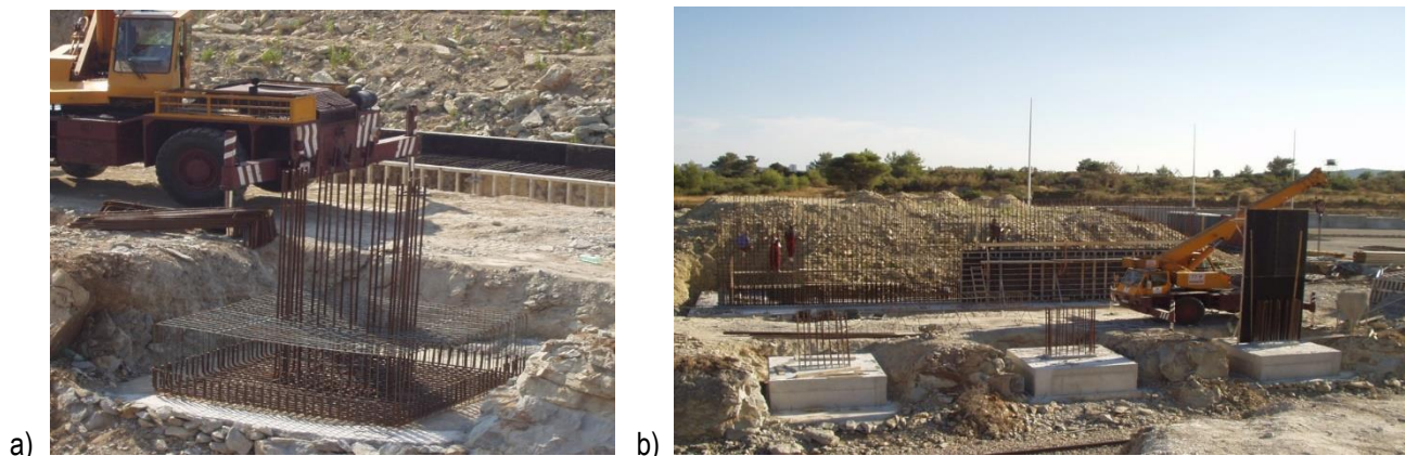
Slika 6.101 – Temelji samci - temelji stupova mosta Emmezeta, Kaštel Sućurac: a) armatura, b) izvedeni temelji
