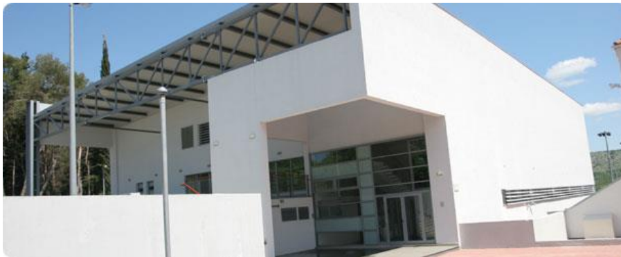
Slika 6.94 – Školska sportska dvorana Dugopolje – konzolni zidni nosač
