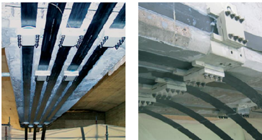
Slika 7.47 – Obnova mosta prednapetim karbonskim trakama
