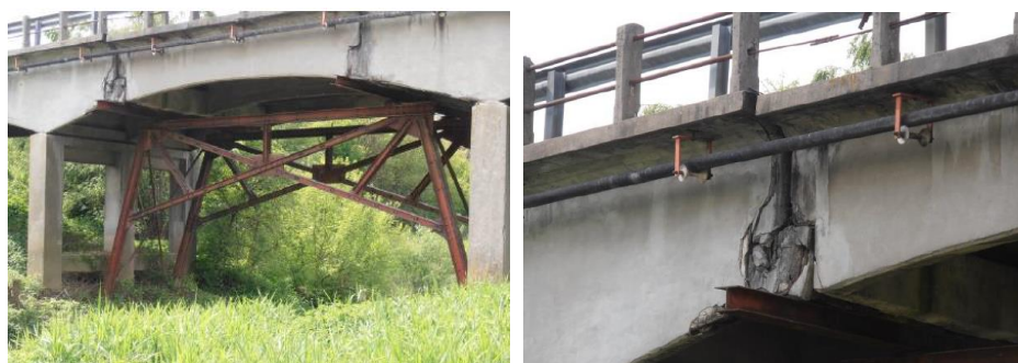
Slika 6.78 – Most preko kanala Bientina, Italija; Slom Gerberova zgloba [15]
