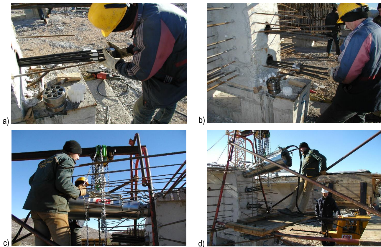
Slika 7.15 – Izvođenje naknadnog prednapinjanja nosača nekog mosta - prednapinjanje
