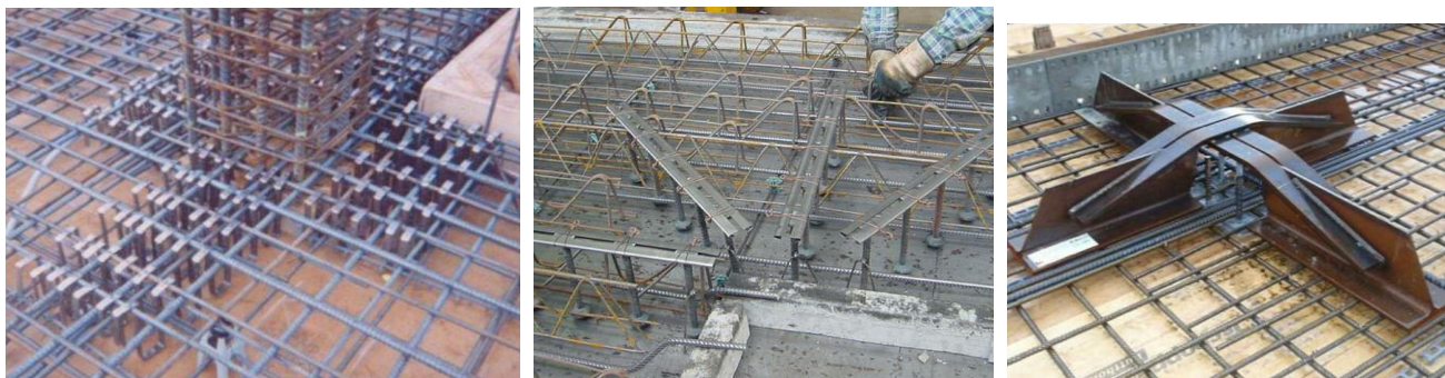
Slika 6.18 – Armatura protiv proboja ploče
