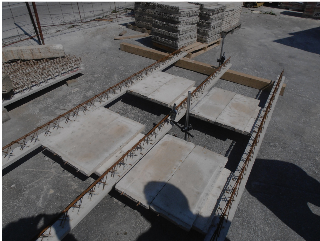
Foto 4.7: Provedba ispitivanja ( II. faza opterećenja)
