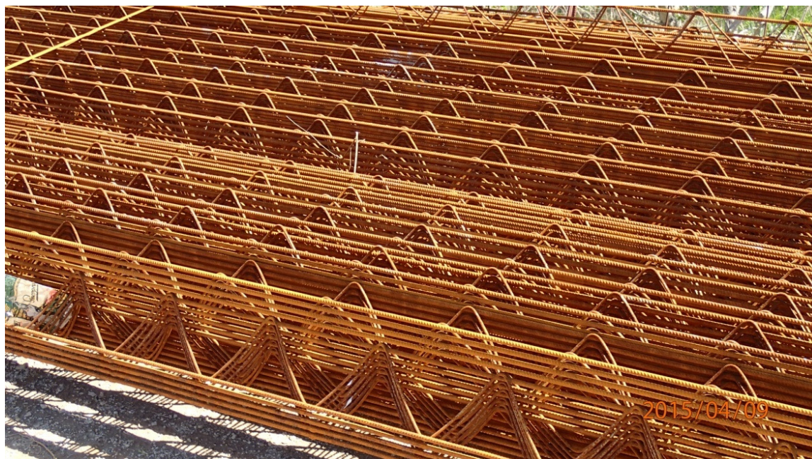
Foto 4.2: Armaturne šipke gredica
