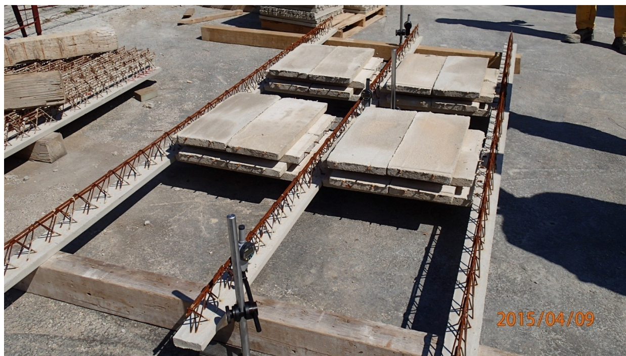
Foto 4.8: Provedba ispitivanja ( IV. faza opterećenja)
