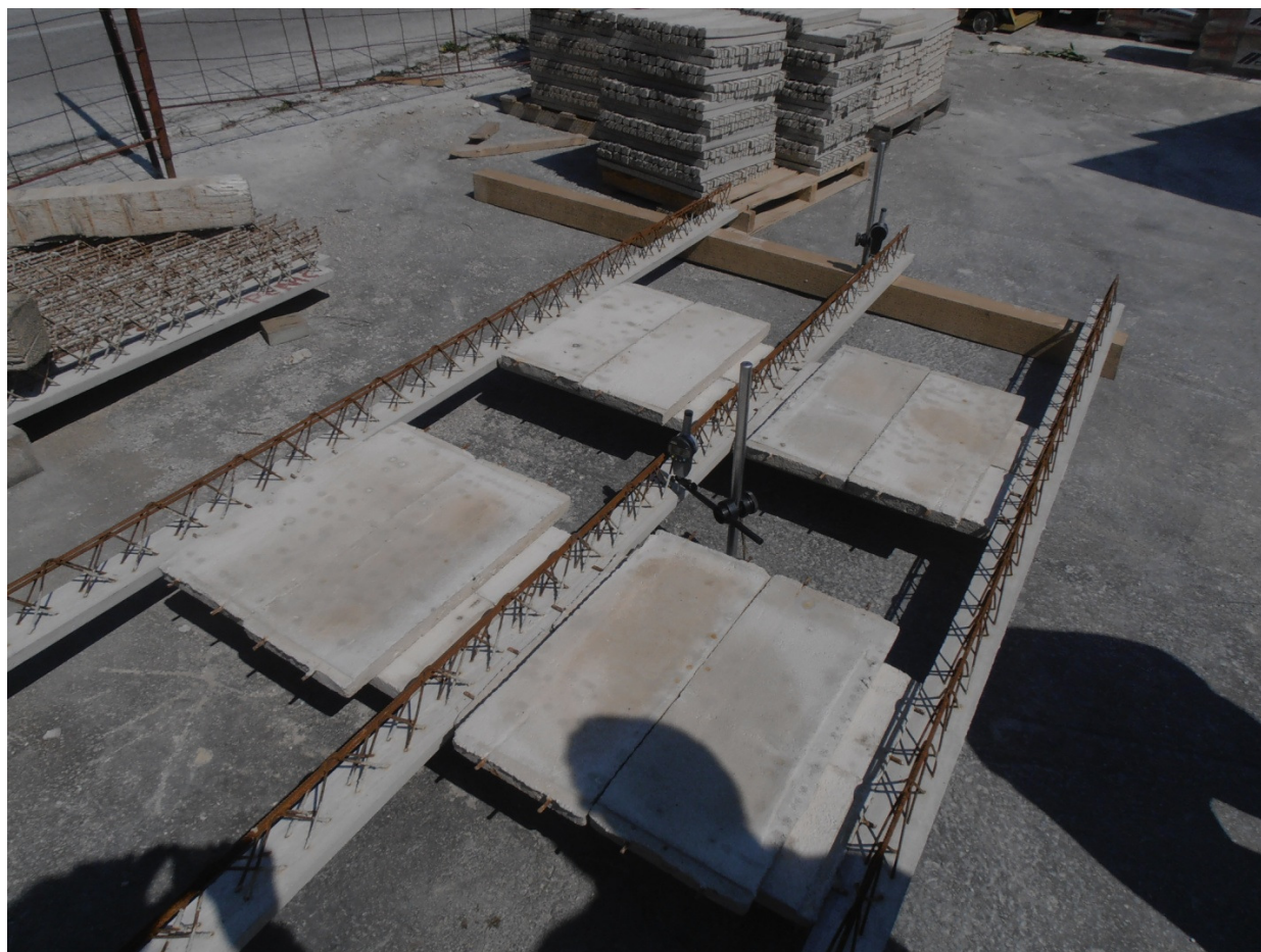
Foto 4.7: Provedba ispitivanja ( II. faza opterećenja)
