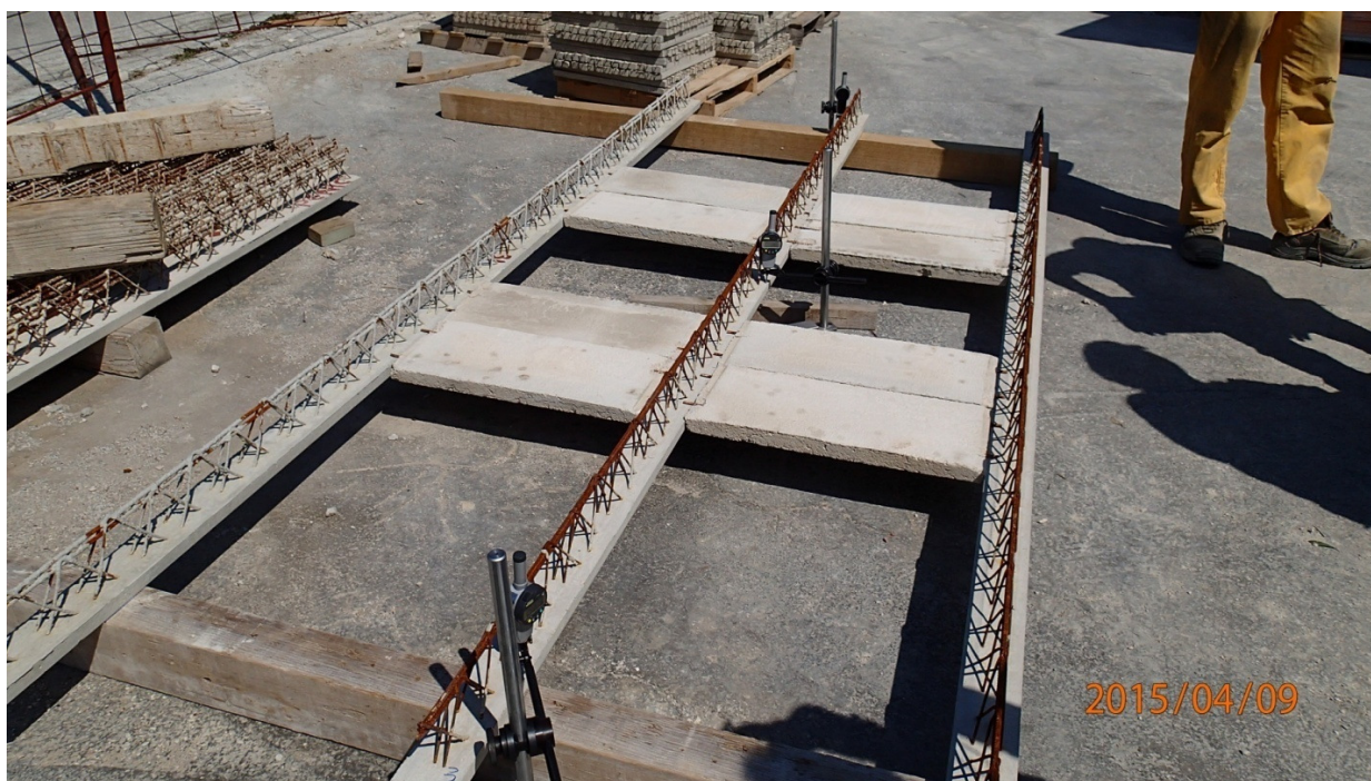
Foto 4.6: Provedba ispitivanja ( I. faza opterećenja)
