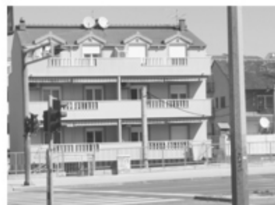
VIŠESTAMBENA ZGRADA na Vukovarskoj ulici
