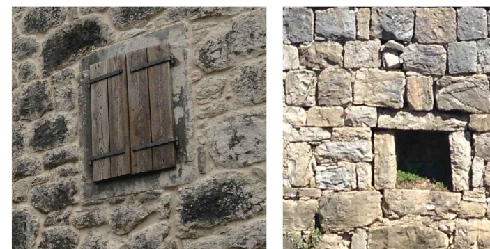
Grafički prilog 59. Prozor sa šķurama, Kostanje; nepravilno klesani nadvoji nad prozorima, Gata / fotografije autora analize
