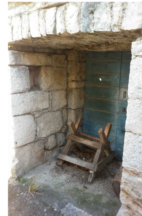
Grafički prilog 39. Arhitektonski elementi u Mužinićima - balatura, vrata s kamenim nadvojem, lučni nadvoj kao ulaz u dvorište / fotografije autora analize
