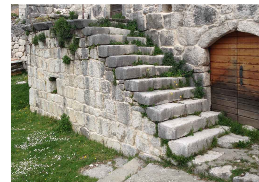
Grafički prilog 19. Balatura / fotografija autora analize
