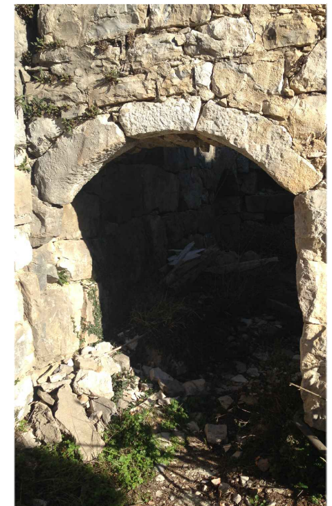
Grafički prilog 39. Arhitektonski elementi u Mužinićima - balatura, vrata s kamenim nadvojem, lučni nadvoj kao ulaz u dvorište / fotografije autora analize
