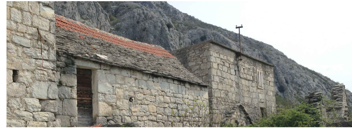
Grafički prilog 54. Gornja zona krova obložena u crijep, donja zona u kamenu, Gata / fotografija autora analize
