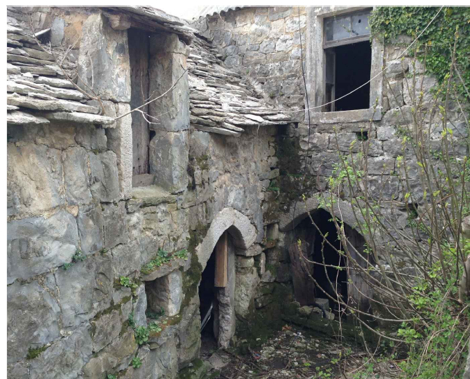
Grafički prilog 34. Nadvoj vrata, prozori i luminar - arhitektonski elementi Mihaljevića / fotografija autora analize
