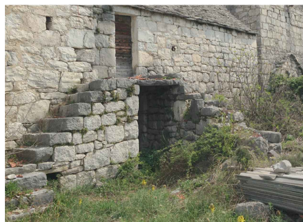
Grafički prilog 57. Skromnija balatura na gornjoj etaži, Ostrvica / fotografija autora analize
