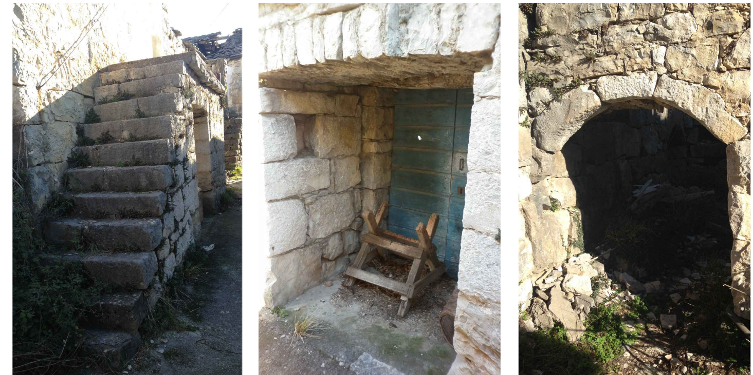
Grafički prilog 39. Arhitektonski elementi u Mužinićima - balatura, vrata s kamenim nadvojem, lučni nadvoj kao ulaz u dvorište / fotografije autora analize
