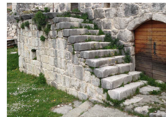
Grafički prilog 19. Balatura / fotografija autora analize
