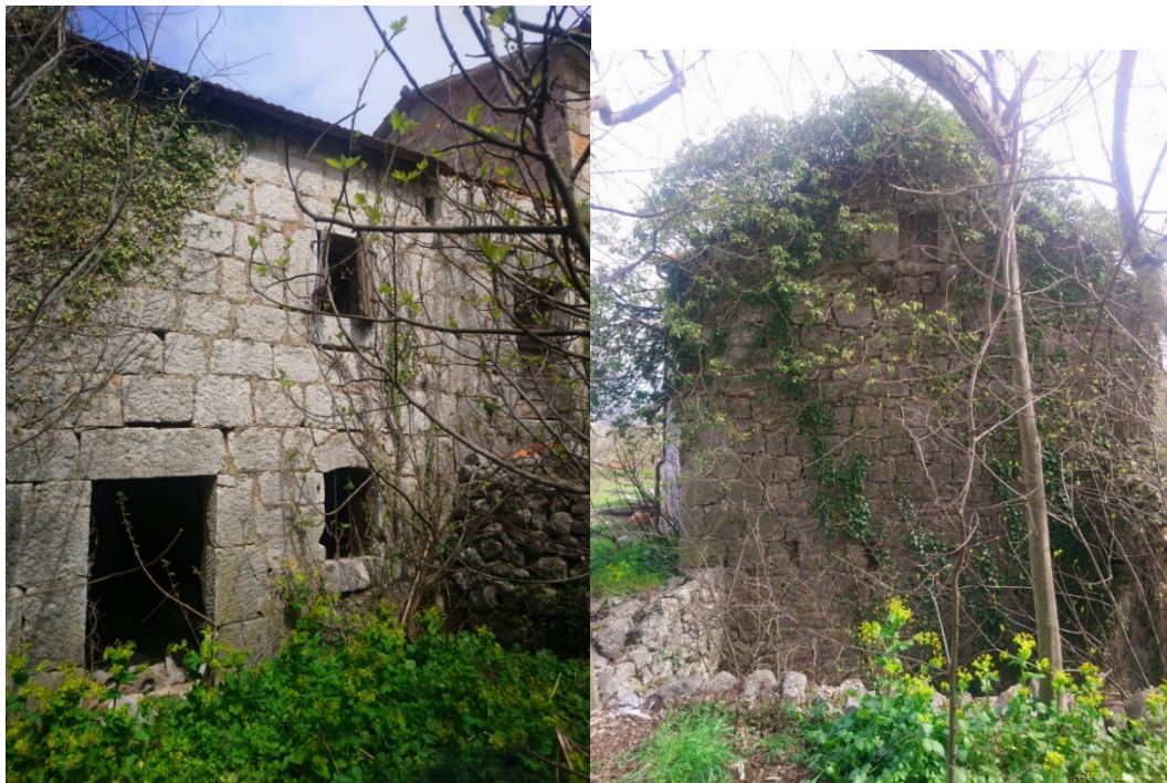
Slika br.2 Južno pročelje (gore) i zapadno pročelje (dolje)
