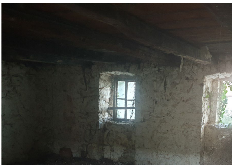
Slika br.3 Unutarnji zidovi i međukatna konstrukcija
