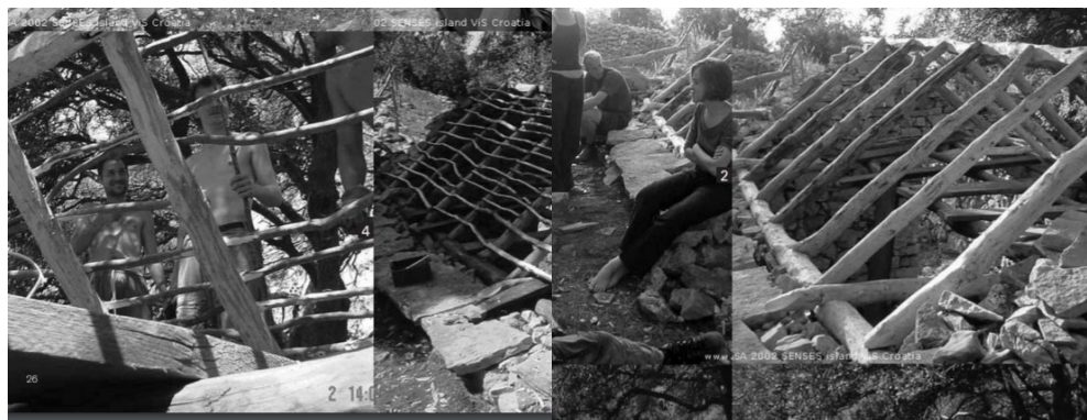
Slika br.4 Krovna konstrukcija [15]
