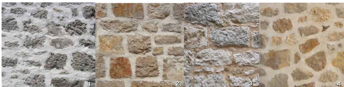
Slika br.9 Ispravni načini fugiranja (mort malo uvučen u odnosu na površinu kamena) [1]
