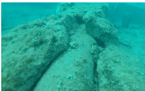
Slike 1.-4. Prikaz oštećenja postojeće betonske zaštite
