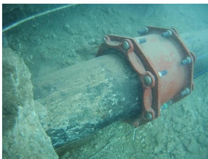
**Slika 27.** Detalj spojnice koja spaja novi cjevovod s postojećom cijevi
