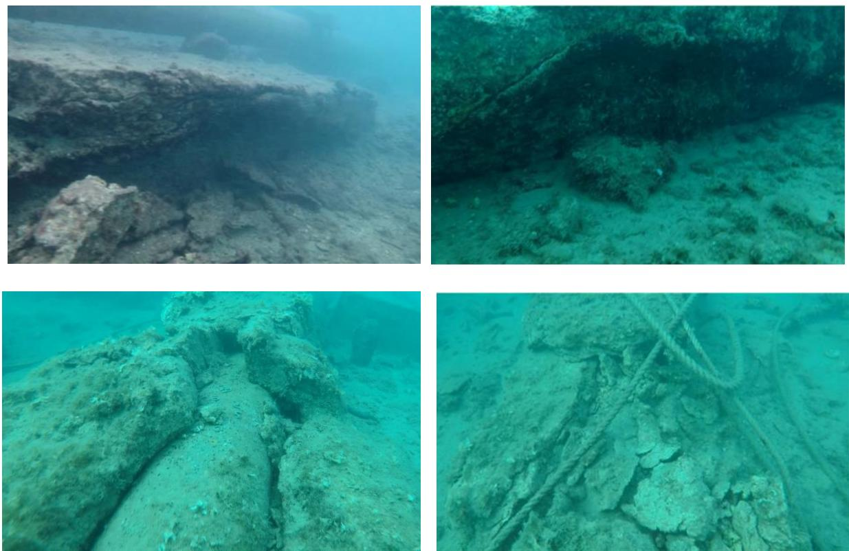
**Slike 1.-4.** Prikaz oštećenja postojeće betonske zaštite
