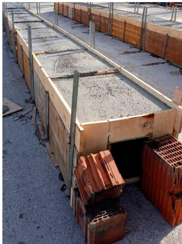
**Slika 23.** Sušenje sekundarnih opteživača u oplati
