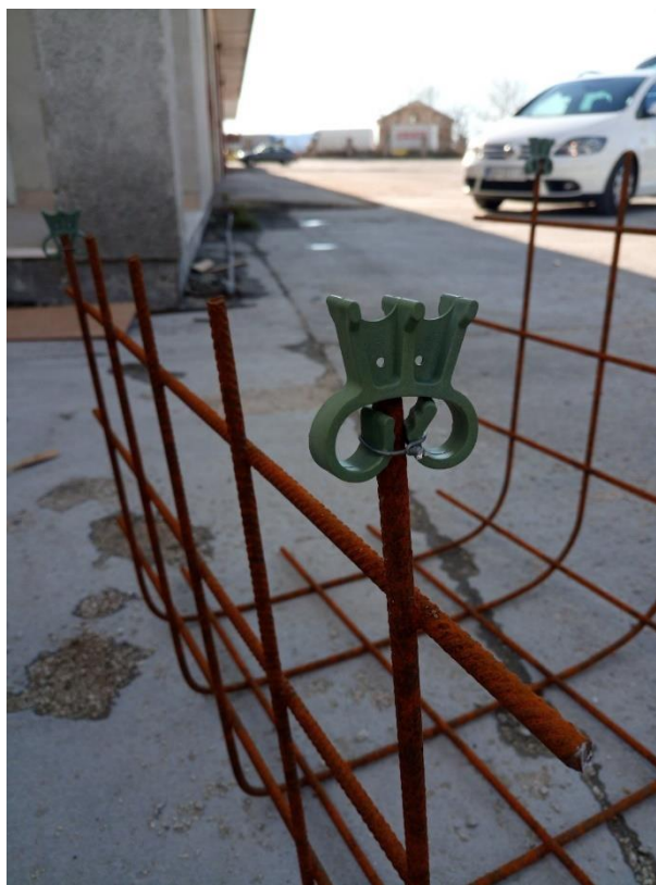
Slika 22. Prikaz armature s pričvršćenim distancerima
