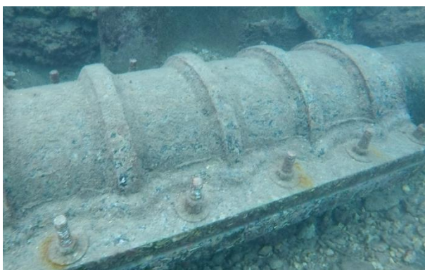
Slike 5. - 12. Prikaz lošeg stanja postojećeg cjevovoda
