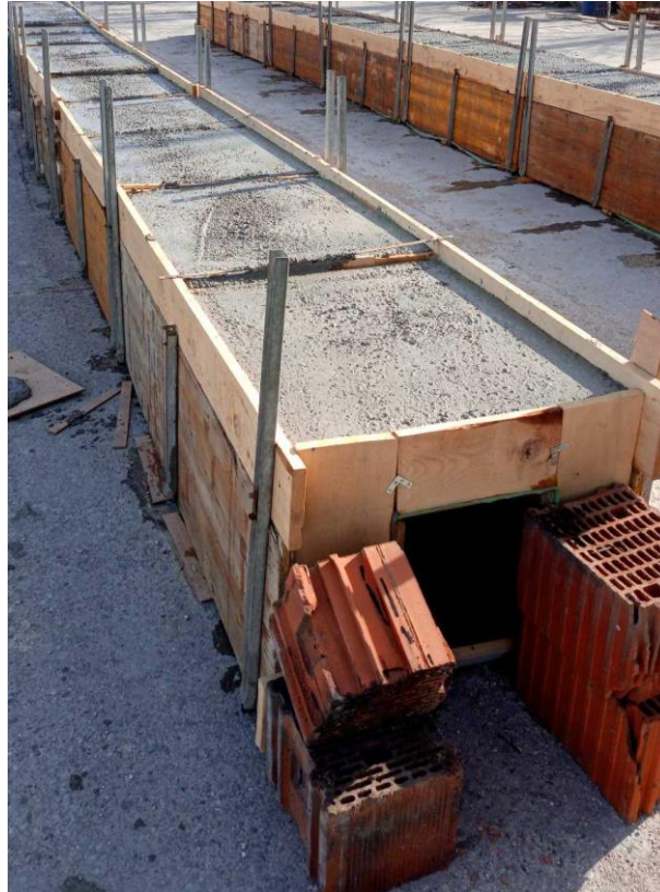
Slika 23. Sušenje sekundarnih opteživača u oplati
