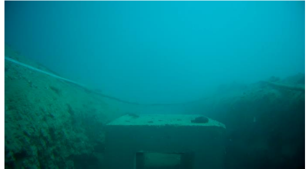
Slika 26. Prikaz sekundarnog opteživača
