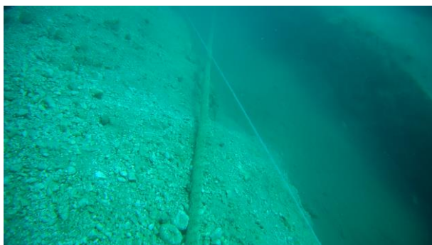
Slika 25. Prikaz iskopa trase
