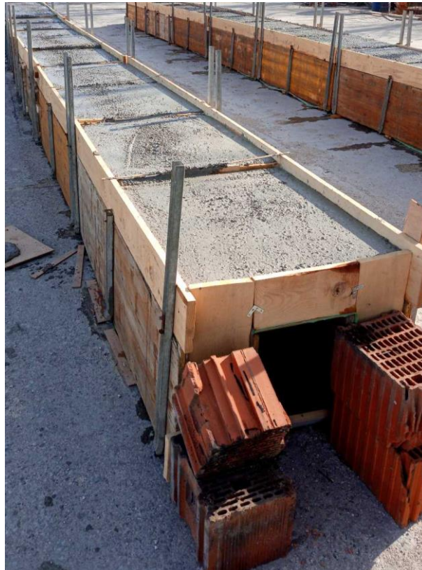
Slika 23. Sušenje sekundarnih opteživača u oplati
