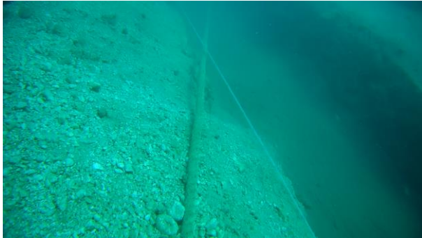
Slika 25. Prikaz iskopa trase
