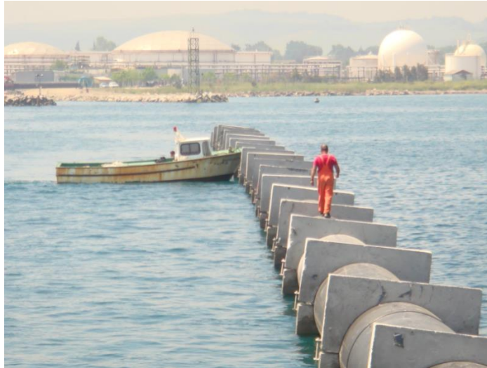
Slika 15. Pridržanje cjevovoda u moru
