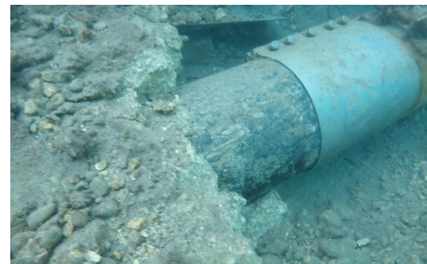
Slike 5. - 12. Prikaz lošeg stanja postojećeg cjevovoda
