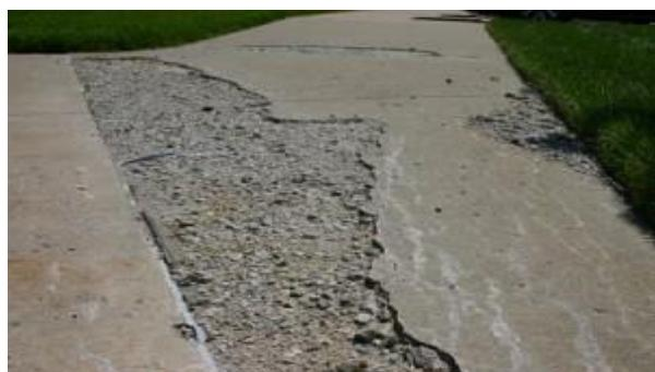
*Slika 3.3 Oštećenje betona zbog smrzavanja [10]*
