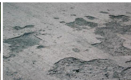
*Slika 3.3 Oštećenje betona zbog smrzavanja [10]*
