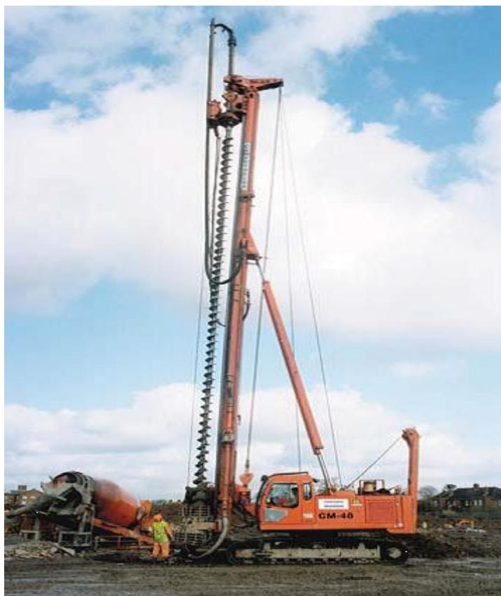
**Slika 1.** Bušeća garnitura za CFA pilote
