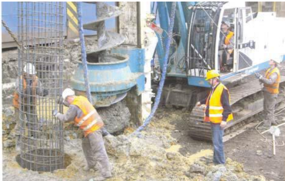
Slika 3. Ugradnja armaturnog koša
