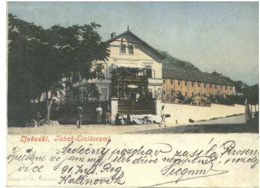
Razglednica - pogled na upravnu zgradu i magazin br.3, 1909.god.
