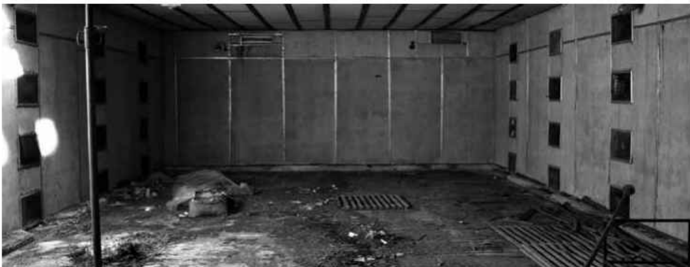
Ferm komora otkupne stanice Stolac
