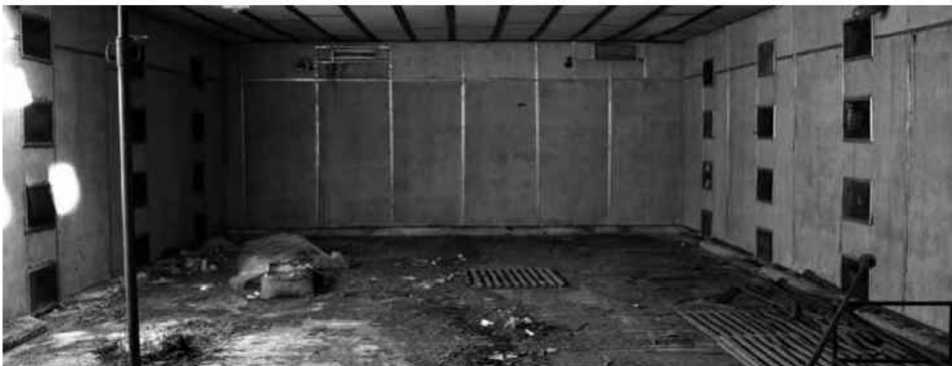
Ferm komora otkupne stanice Stolac
