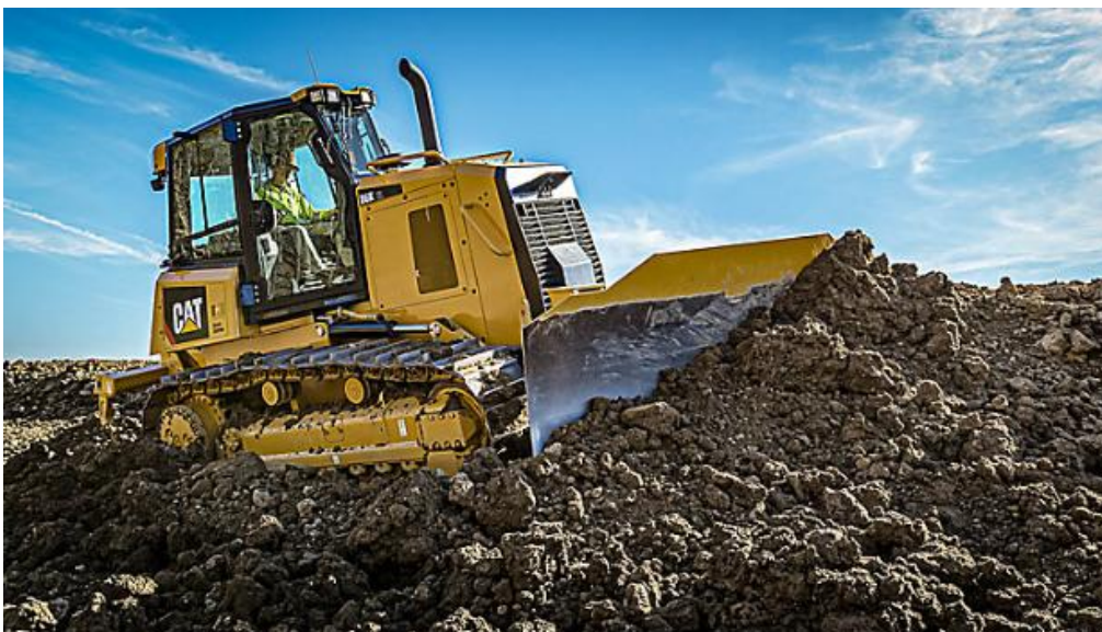
Slika 4.1 - Buldozer Cat D6K
