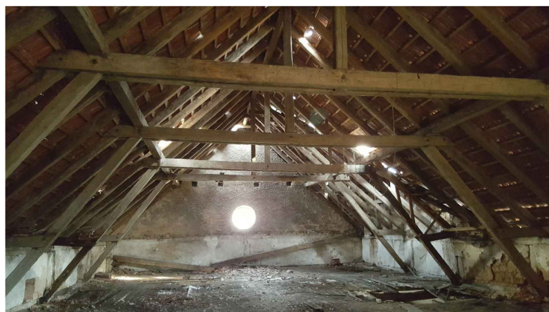
② Drvena konstrukcija kosog jednostrešnog krova bez izolacije i prekrivena crijepom
