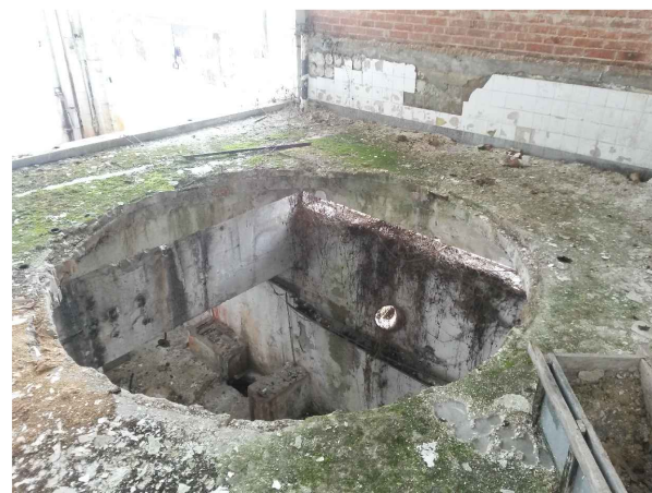
④ Varioni podrum unutar kojeg se nalazio kotao za kuhanje pive
