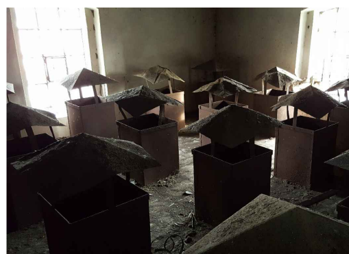
① Cijevi za odvođenje zraka prilikom sušenja slada u sušari
