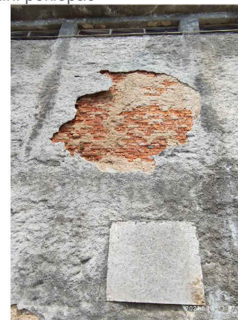
③ Konstrukcija od opeke prekrivena žbukom
