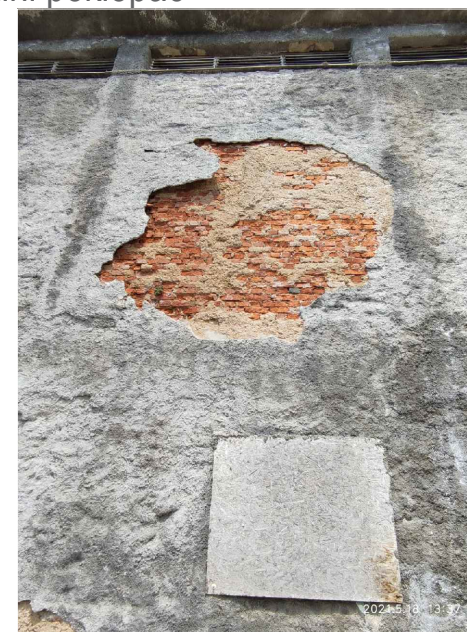
③ Konstrukcija od opeke prekrivena žbukom
