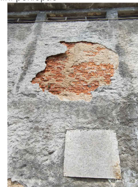
③ Konstrukcija od opeke prekrivena žbukom
