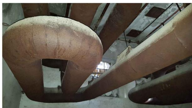
① Cijevi za odvođenje zraka prilikom sušenja slada u sušari
