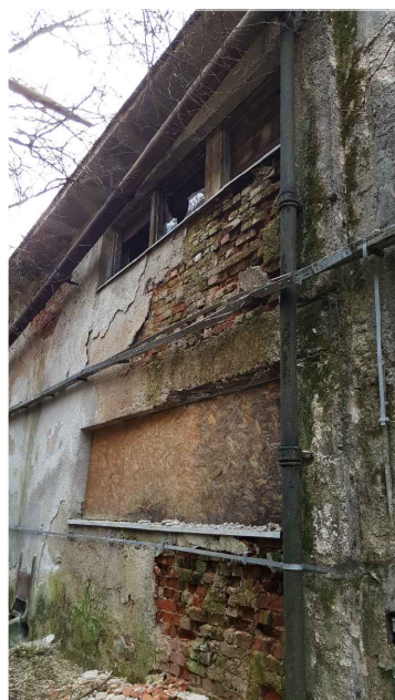
③ Konstrukcija od opeke ③ Betonski nosivi stup prekrivena žbukom
