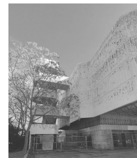
_vanjsko stubište za krovnu terasu
