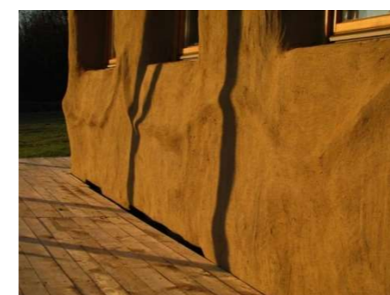
Ilovača kao žbuka, izvor: https://www.emajstor.hr/
