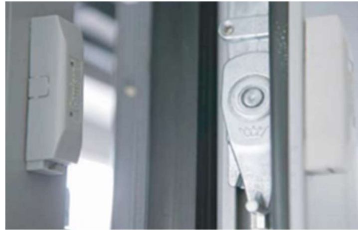
mikroprekidač na prozoru, izvor: EIHP
