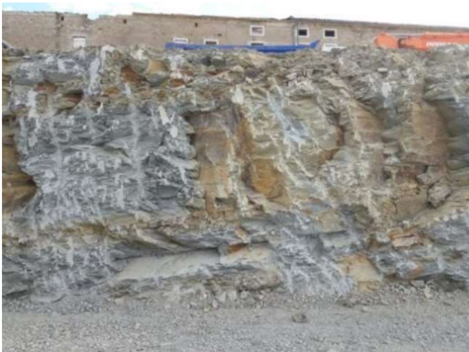
Slika 2.1 Prikaz zasjeka u laporu
