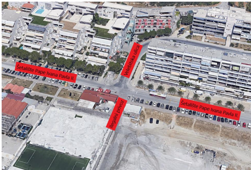
Slika 5. Prikaz postojećeg stanja
