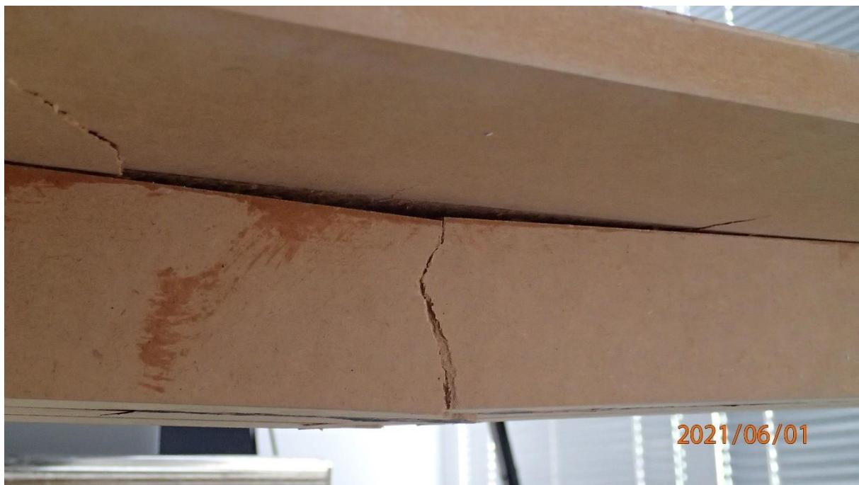
Slika 65: Pukotine nosača na unutarnjem licu poprečnog presjeka nosača
