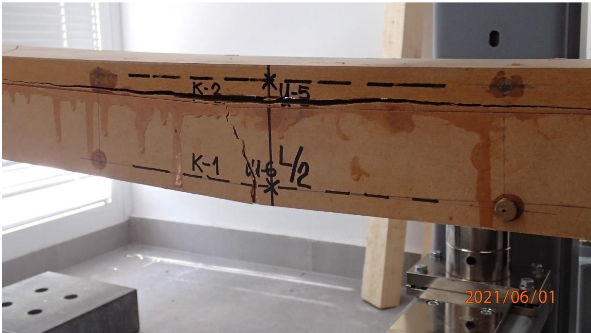
Slika 64: Pukotine nosača na vanjskom licu poprečnog presjeka nosača
