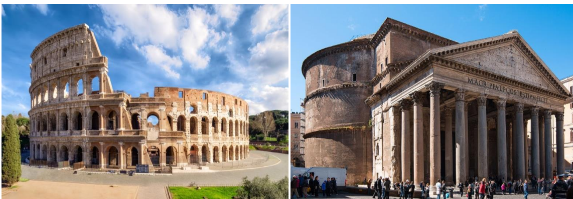
Slika 3.1. Rimske zidane građevine: a) Koloseum u Rimu; b) Pantheon u Rimu [28,29]
