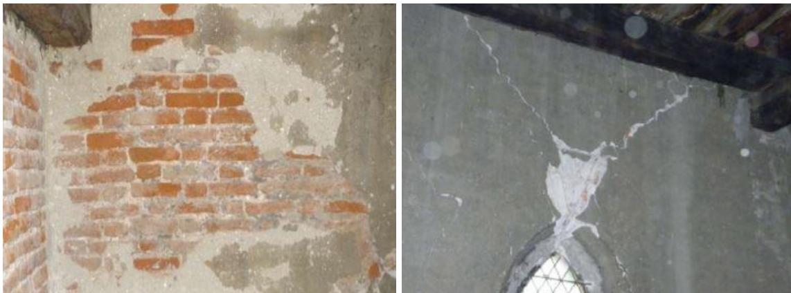
**Slika 2.5. Prikaz zidova zvonika: a) Karakteristično ziđe s vidljivim načinom gradnje; b) Unutarnja obrada ziđa s prisutnim oštećenjem [2].**
