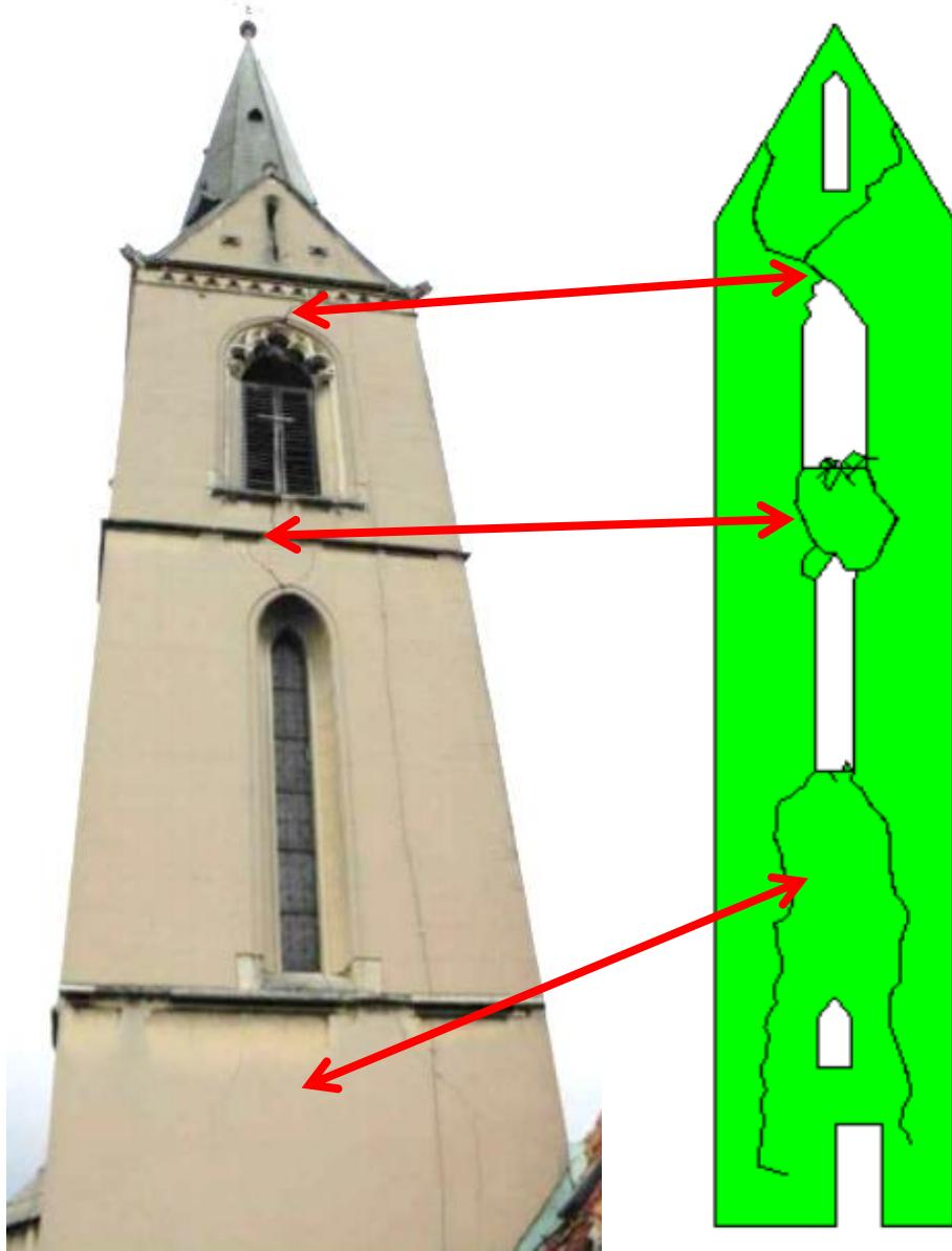
**Slika 6.10.** Prikaz podudaranja oštećenja modela i stvarne konstrukcije.
