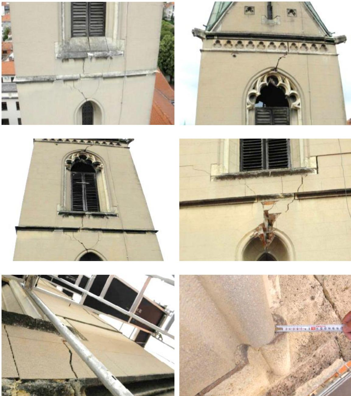
**Slika 2.6.** Prikaz šteta na zvoniku: a) Prikaz pukotina nadvoja na koti +27.26; b) Prikaz pukotina nadvoja na vrhu zvonika; c) Prikaz pukotina nadvoja na koti +27.26 i na vrhu zvonika; d) Detaljni prikaz pukotina nadvoja na koti +27.26; e) Prikaz pukotina zida zvonika; f) Šteta nastale uvrtanjem konstrukcije [3].
