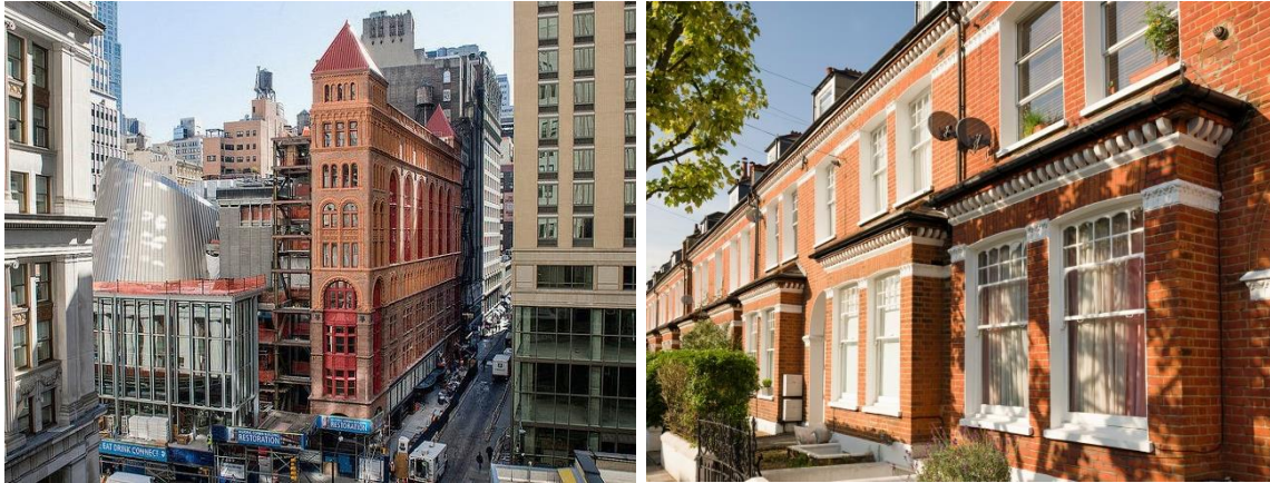
Slika 3.3. Gradnja opekom u 19. stoljeću: a) Corbinov neboder u New Yorku; b) Viktorijanske kuće u Engleskoj [32,33].
