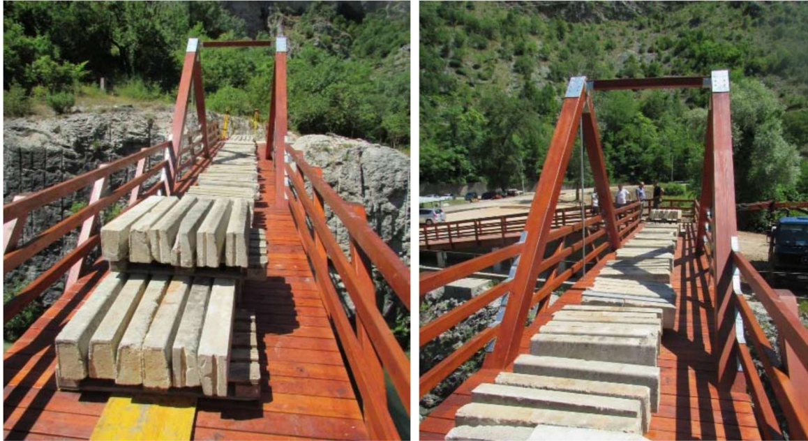
Slika 2.1. Pokusno opterećenje na mostu preko rijeke Tihaljine [3]
