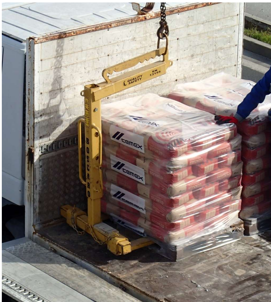
Slika 4.7. Palete s vrećama cementa korištene za probno opterećenje
