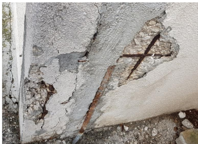
Slika 8. Problemi uslijed nedostatka zaštitnog sloja
