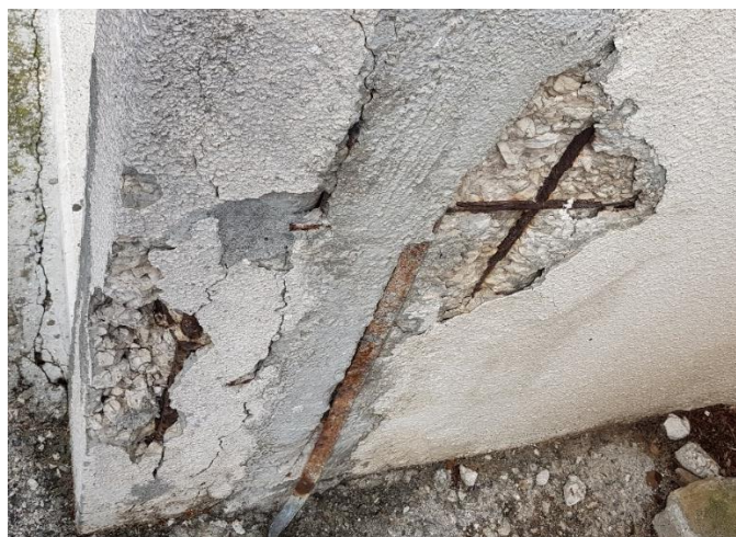
Slika 8. Problemi uslijed nedostatka zaštitnog sloja
