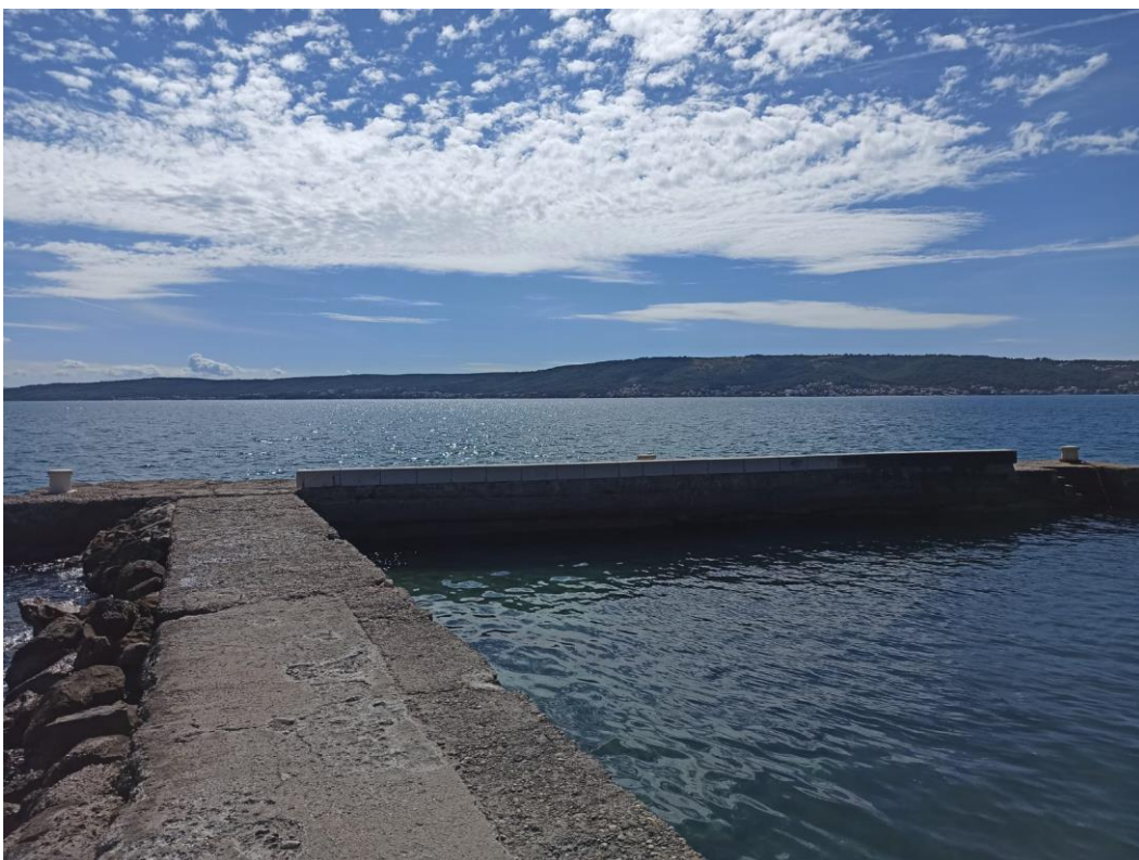
Slika 1.4 Prilaz južnom lukobranu
