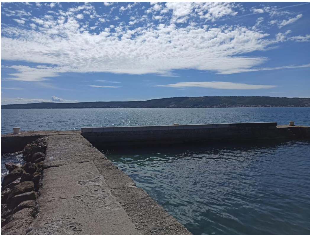
Slika 1.4 Prilaz južnom lukobranu
