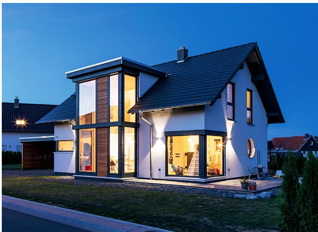
Slika 1. Primjer montažne kuće
