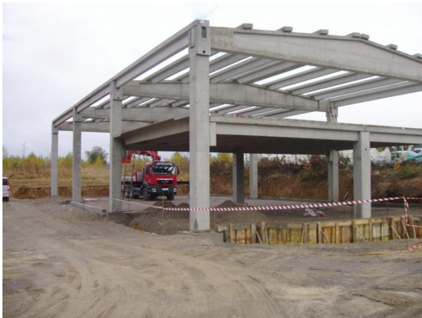
Slika 7. Montažna betonska gradnja
