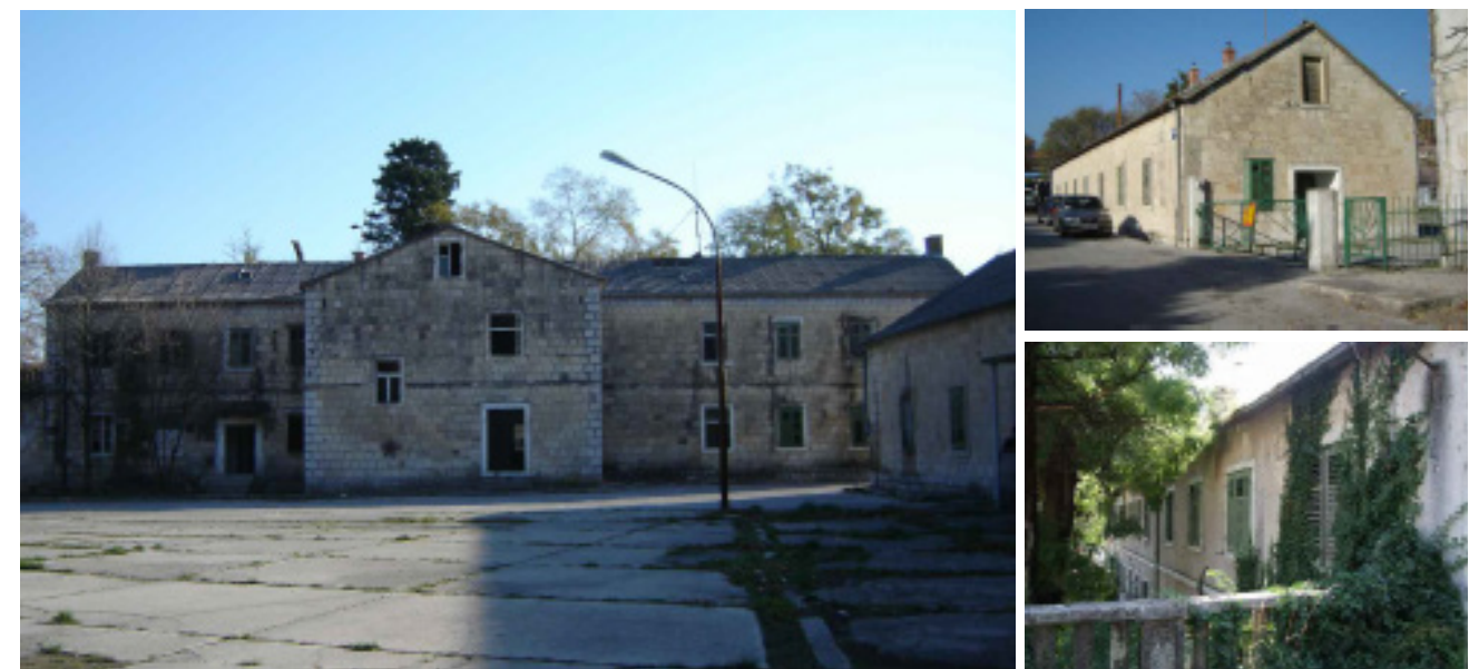
Gospodarska kuća Šuić s pomoćnim objektom (današnje stanje)
