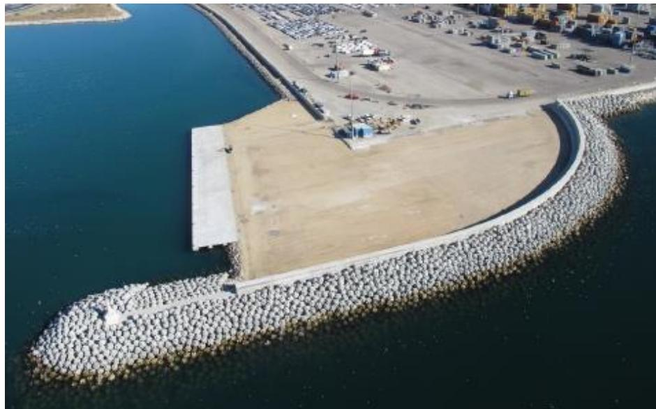
Slika 4.7.1. Izvedba trupa lukobrana s Cubipod primarnom zaštitom
