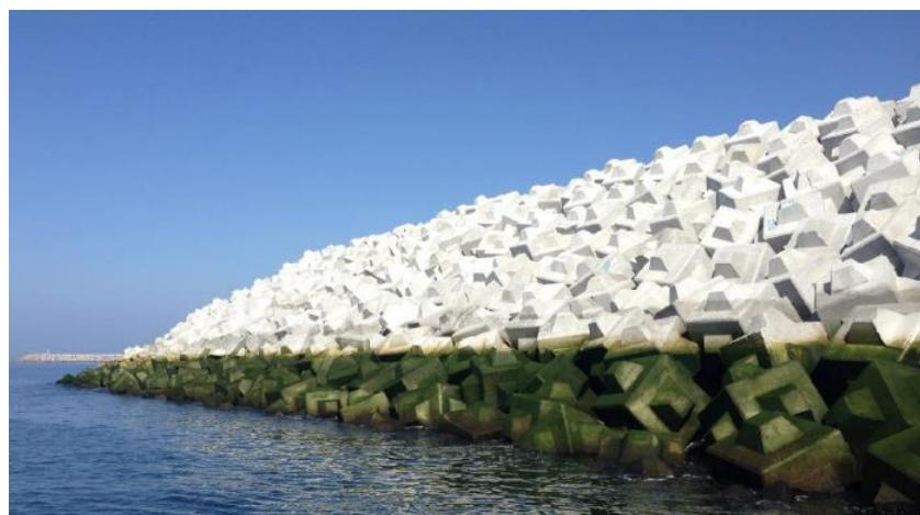
Slika 4.7.2. Pokos trupa lukobrana s Cubipod primarnom zaštitom
