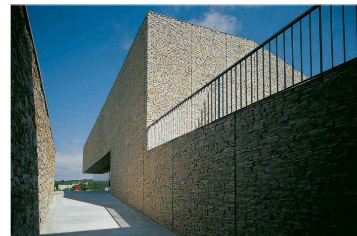
Dvorana u Balama 3LHD-a dobar je primjer suvremene aplikacije kamena na pročelje kuće (prefabricirani paneli).
