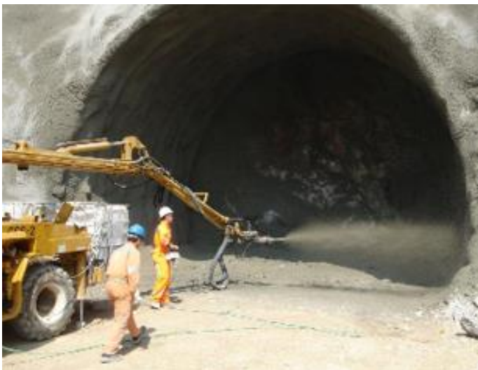
Slika 3. Primjena mikroarmiranog betona u izgradnji tunela [6]
