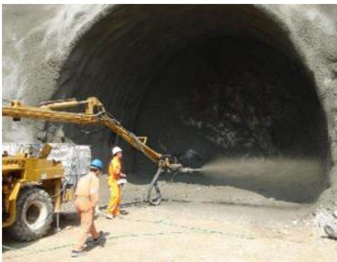
Slika 3. Primjena mikroarmiranog betona u izgradnji tunela[6]
