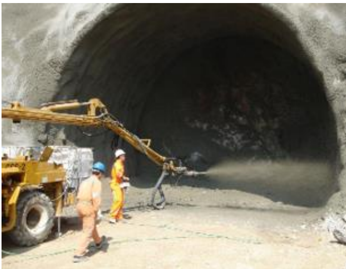
Slika 3. Primjena mikroarmiranog betona u izgradnji tunela [6]
