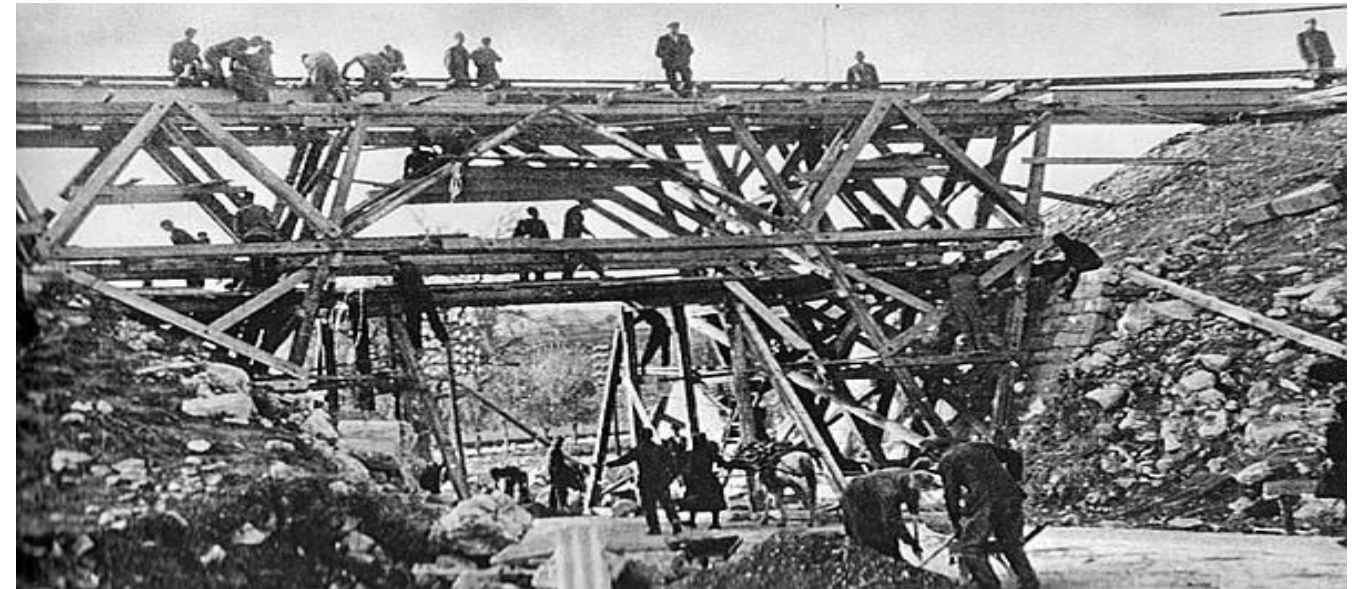
Obnavljanje željezničkog mosta Split-Sinj
