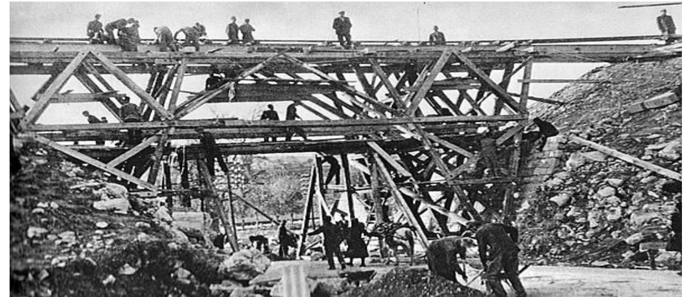
Obnavljanje željezničkog mosta Split-Sinj
