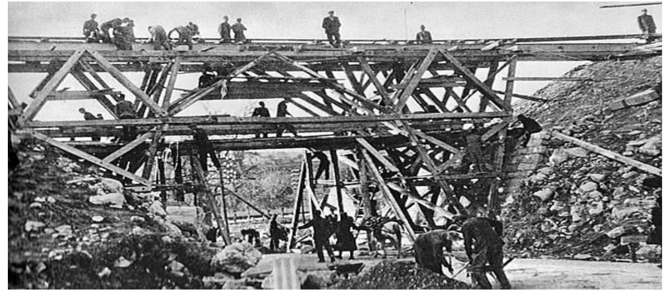
Obnavljanje željezničkog mosta Split-Sinj
