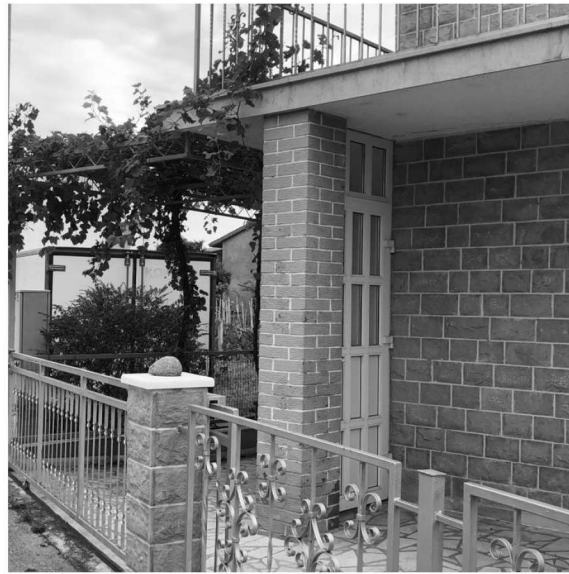
Nedovršena novogradnja, okolica parcele
