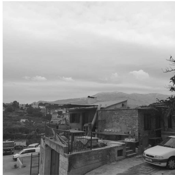
Kontakt nedovršenih fasada, okolica parcele
