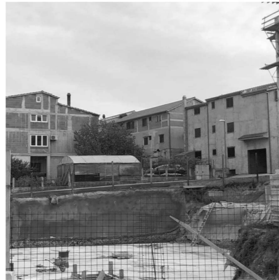
Nedovršeni objekt, okolica parcele
