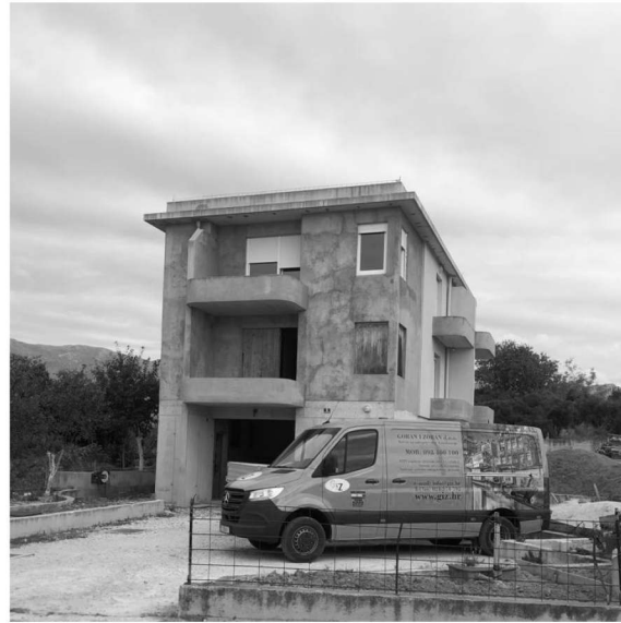
Nedovršena novogradnja, okolica parcele
