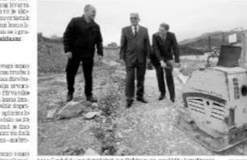
Radovi na izgradnji infrastrukture u Sirobuji
