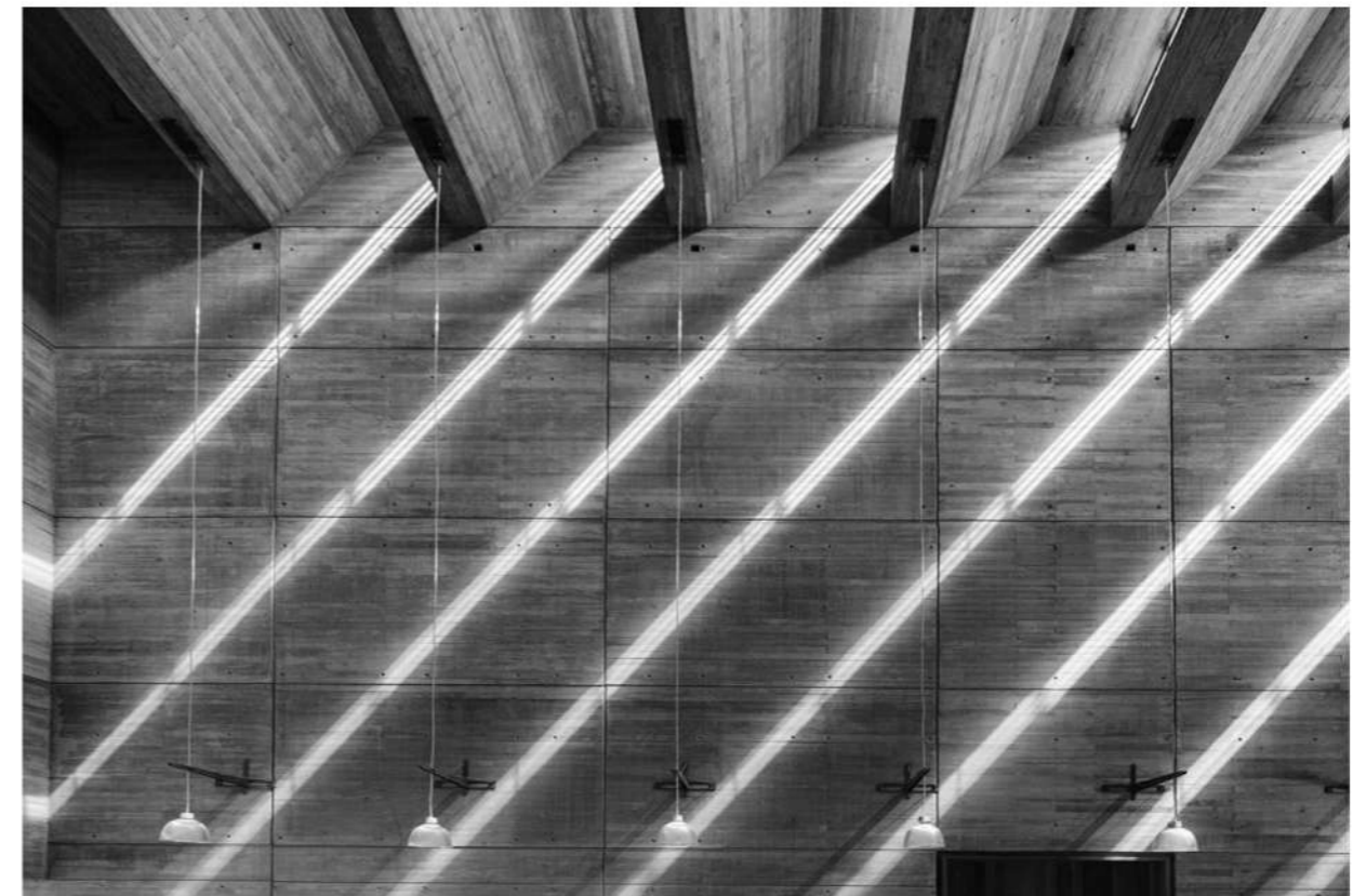
Mendaro Corsini Arquitectos, Edificio del Archivo Histórico
