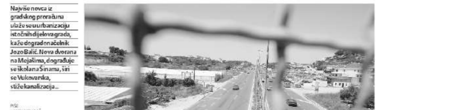
Radovi na izgradnji infrastrukture u Sirobuji
