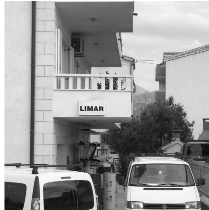
Stambena zgrada s obrtom u prizemlju, zapad
