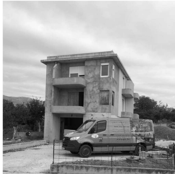
Nedovršena novogradnja, okolica parcele
