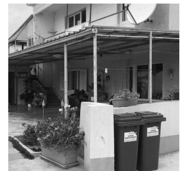
Nadstrešnica - vanjski dnevni boravak
