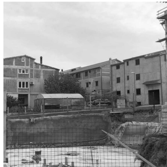
Nedovršeni objekt, okolica parcele
