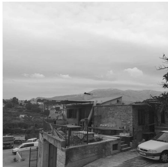
Kontakt nedovršenih fasada, okolica parcele
