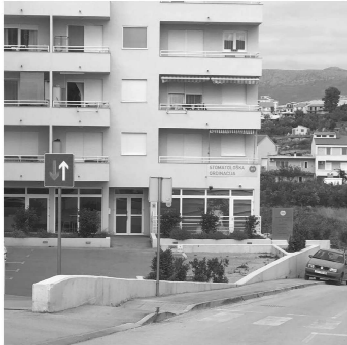
Stambena zgrada, sjevero-zapad
