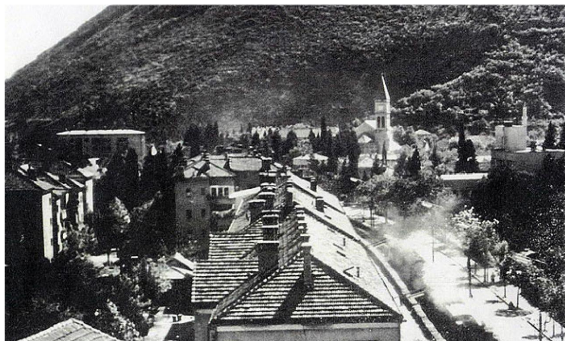
Željeznička pruga na mjestu današnjeg Bulevara (izvor nepoznat)
