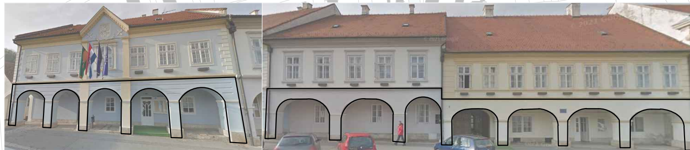
GRAĐEVINE NA ZAPADNOM DIJELU TRGA SVETOG TROJSTVA
