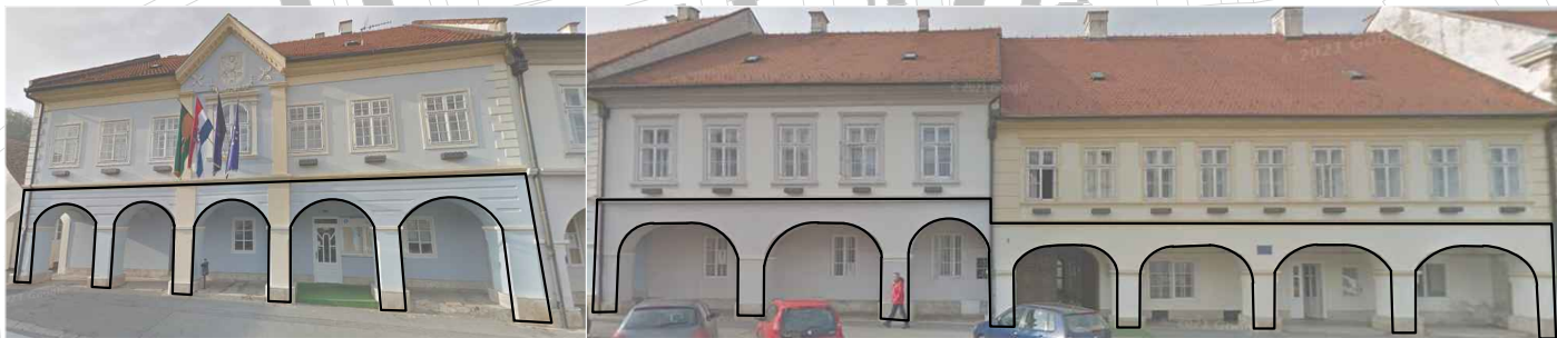
GRAĐEVINE NA ZAPADNOM DIJELU TRGA SVETOG TROJSTVA
