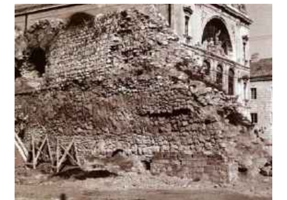
_17 Priuli - unutarnje lice zidanog dijela
