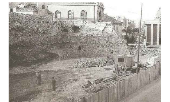
_16 Radovi prilikom probijanja sjevernog zida bastiona, 1951. g.
