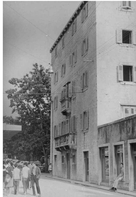
32 Zgrada glazbene škole u Ulici kralja Tomislava
