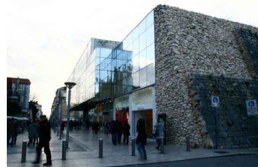
_28 Detalj intervencije zapadnog dijela bastiona Priuli iz 2011. g.
