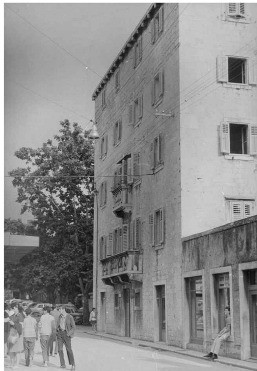
...32 Zgrada glazbene škole u Ulici kralja Tomislava
