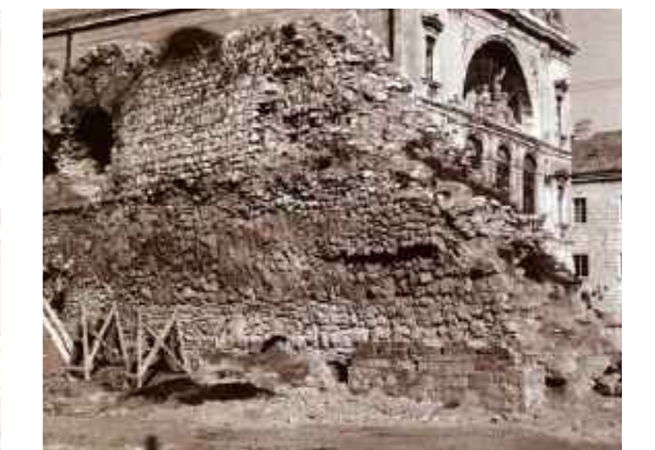
_17 Priuli - unutarnje lice zidanog dijela
