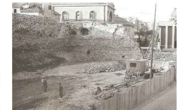
_16 Radovi prilikom probijanja sjevernog zida bastiona, 1951. g.
