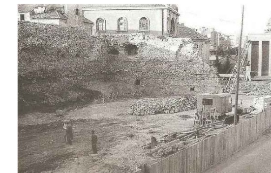
_16 Radovi prilikom probijanja sjevernog zida bastiona, 1951. g.
