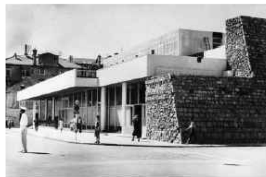
_25 Izvedeni objekt - spoj s bedemom
