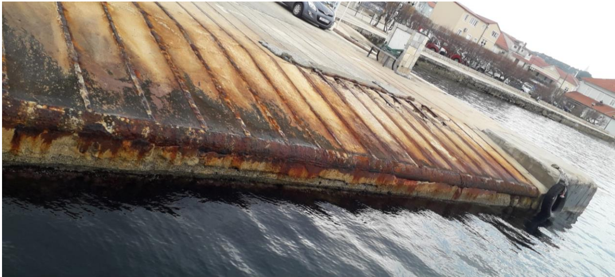
Slika 2.4. Oštećenje betona
