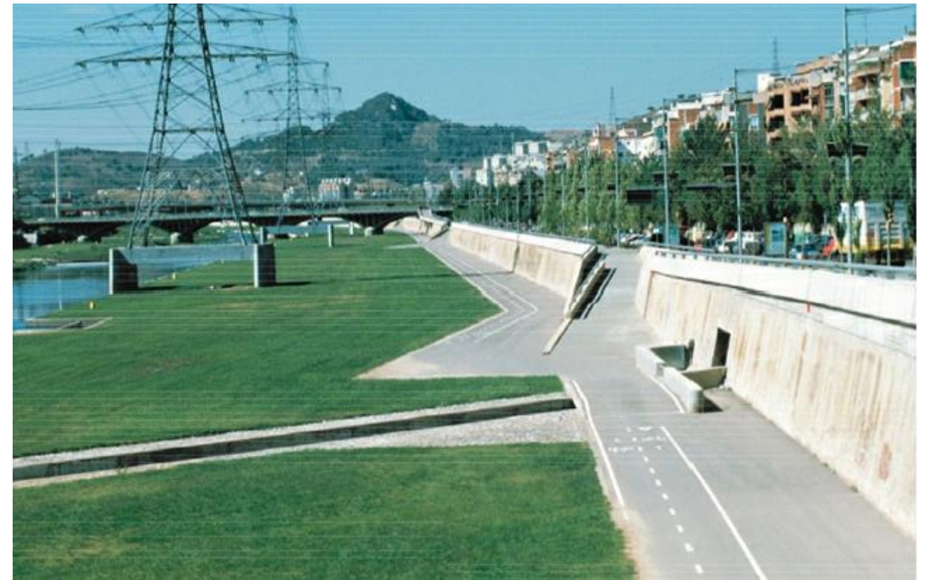
SLIKA 13 - pristupne rampe koje tangiraju šetnicu
