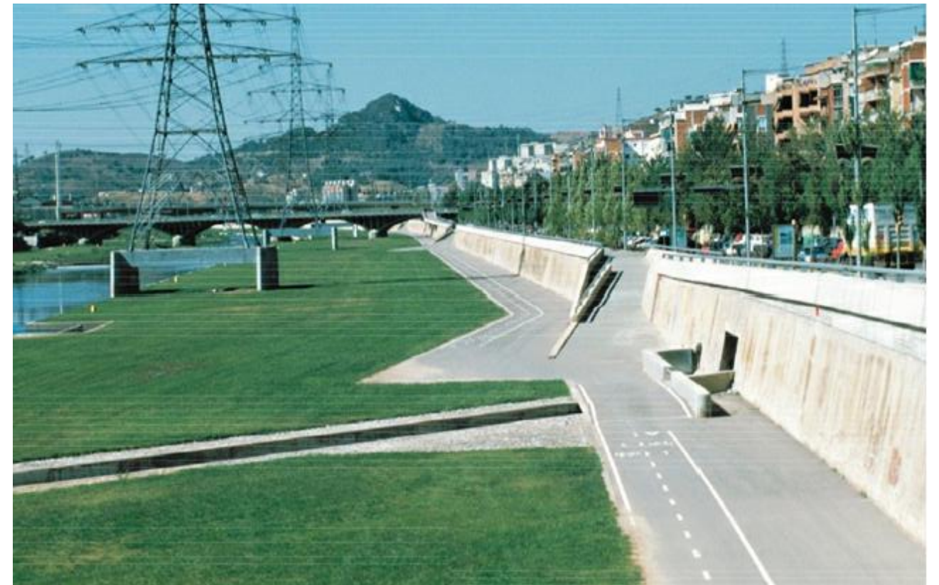
SLIKA 13 - pristupne rampe koje tangiraju šetnicu
