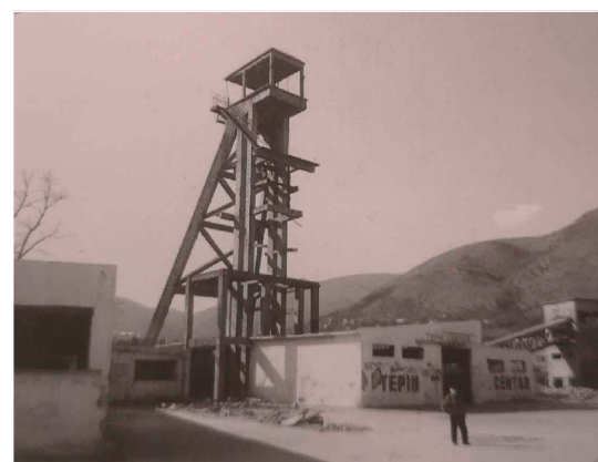
Izvozno okno - jama Novo okno
