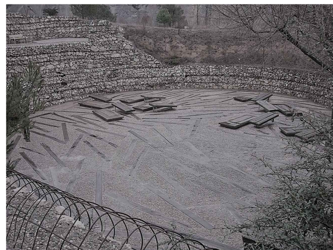
zidovi od gabiona
