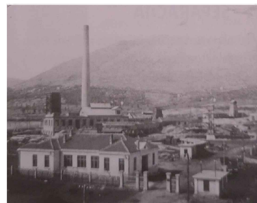
Termoelektrana s rashladnim uređajem
